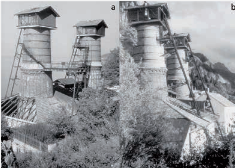
Abb. 11: Die beiden Hinteren Brennöfen der Staininger Kalkwerke mit Blick Richtung Nordwesten (a) bzw. nach Südosten (b) kurz vor ihrer Sprengung im Jahre 1971. Gut zu erkennen sind auch die Führungen der Kalkaufzüge die 1932 in Betrieb genommen wurden.
