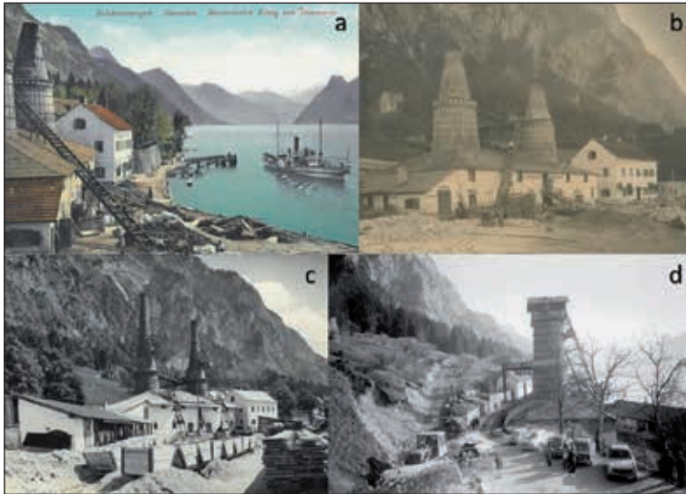
Abb. 3: Die beiden Hinteren Brennöfen der Staininger Kalkwerke und ihr technischer Wandel im Laufe des 20. Jhdts. Die Öfen wurden vorerst immer höher, zuletzt wieder niedriger, weil mit einem Ventilator versehen. Auf (b) zeigen an der linken Hausecke (Anbau für Küche und Schmiede) Hochwassermarken des Traunsees der Jahre 1897 und 1899, dass das Erdgeschoß des Werkes dabei fast zur Gänze unter Wasser stand. Rechts im Bild ist auch ein Zille zu sehen, die dem Kalktransport diente. Bild (d) stammt aus dem Jahre 1969, kurz vor dem Abbruch des Werkes.
